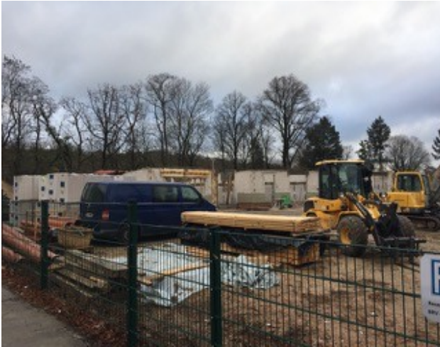
vom seitlichen Grundstück aus
